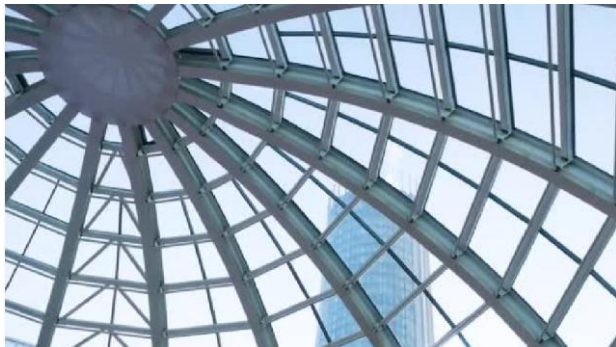
Soffitto a vetri:
