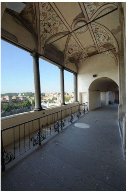
loggia di Giulio II
